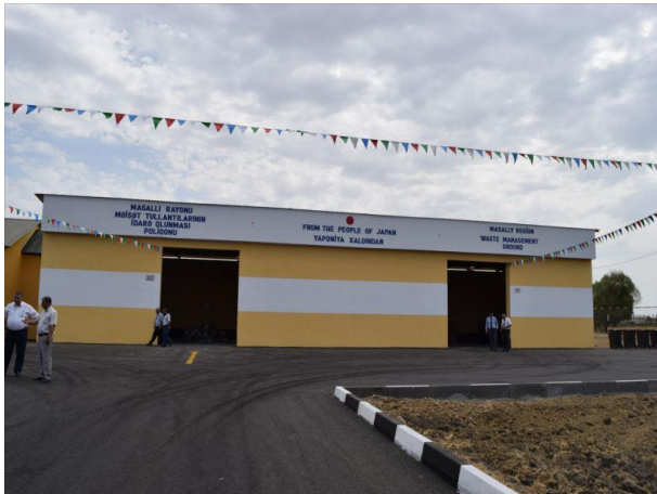
Layihə çərçivəsində inşa olunan tullantıların idarə olunması mərkəzi
